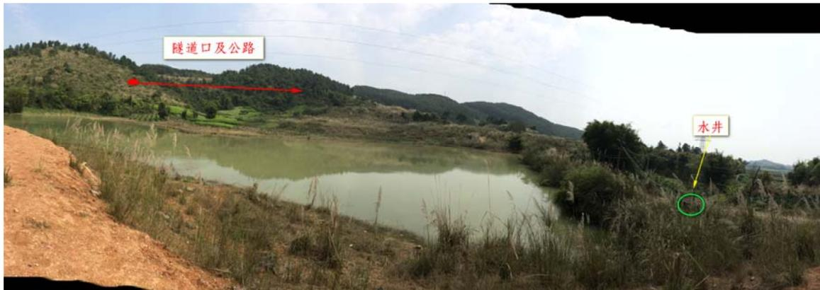
龙平隧道长度 540m，坡度-2.5%，基本东西走向，隧道西侧紧靠水源保护区边界。一般中隧道采取单向施工。从工程角度，隧道施工由低标向高标正向施工，隧道涌水可顺坡自流排出；若从高标向低标逆向施工，隧道涌水需用水泵抽出。由于龙平隧道西侧出口（低标）临近潘村饮用水源边界，在此要求采用由高标向低标（由东向西方向）逆向施工，隧道涌水在隧道东侧排出，不在潘村水源地汇水范围内，对水源影响不大。
